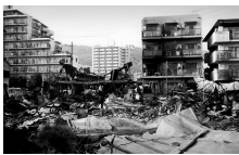
震災で被害を受けた住宅
