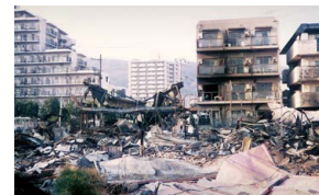
震災で被害を受けた住宅
