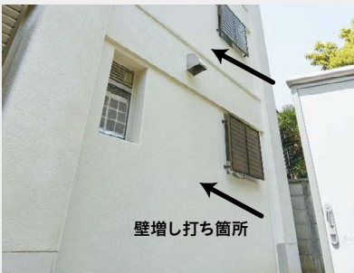
耐震増し打ち壁
