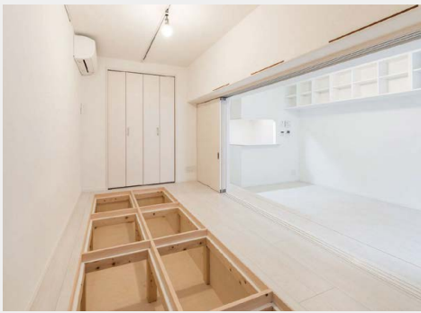
逆梁工法を利用した床下収納
