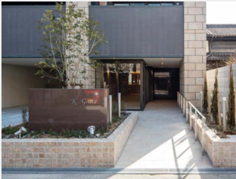
スロープ・手すり
