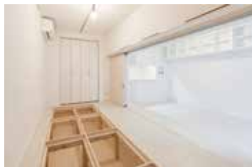
〈逆梁工法を利用した床下収納〉
