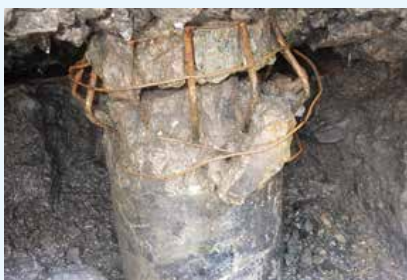
〈損傷した杭の様子〉
