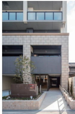
〈スロープ・手すり〉
