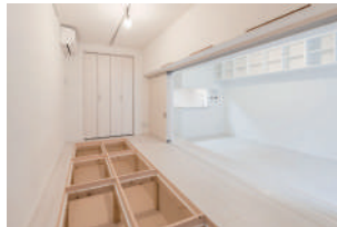
〈逆梁工法を利用した床下収納〉
