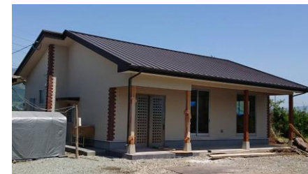
災害復興住宅融資（高齢者向け返済特例）を利用して建設された住宅
