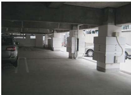
〈工事箇所：免震装置〉
