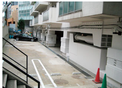
〈工事箇所：免震装置〉
